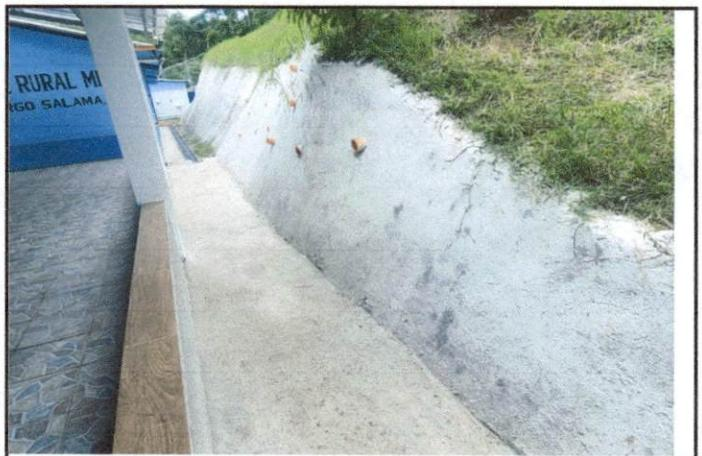
Foto 4: Remanentes complemento de muro de contension en área de Pórtico y Emparrillado de canal existente.
